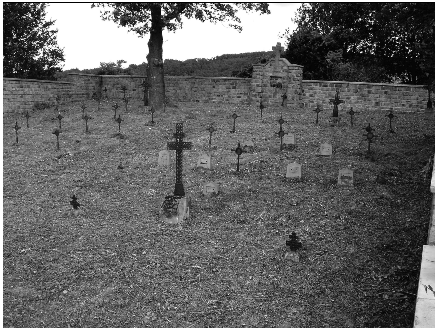
Fot. nr 3 — Cmentarz wojskowy nr 77 w Ropicy Górnej. Widok na obiekt po pracach Stowarzyszenia (fot. K. Ruszata)
